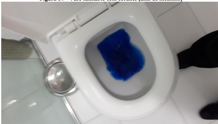
Figura 14 – Vaso sanitário com corante (azul de metileno)
